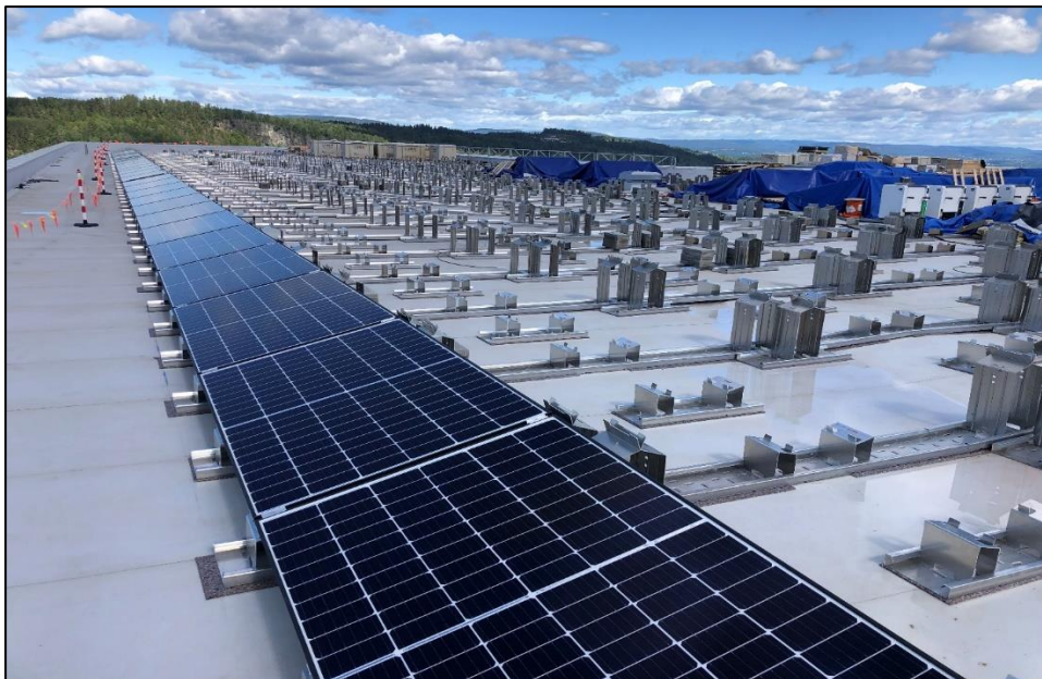
Figur 25. Solceller installeres på nye Torvbråten skole (2020).
