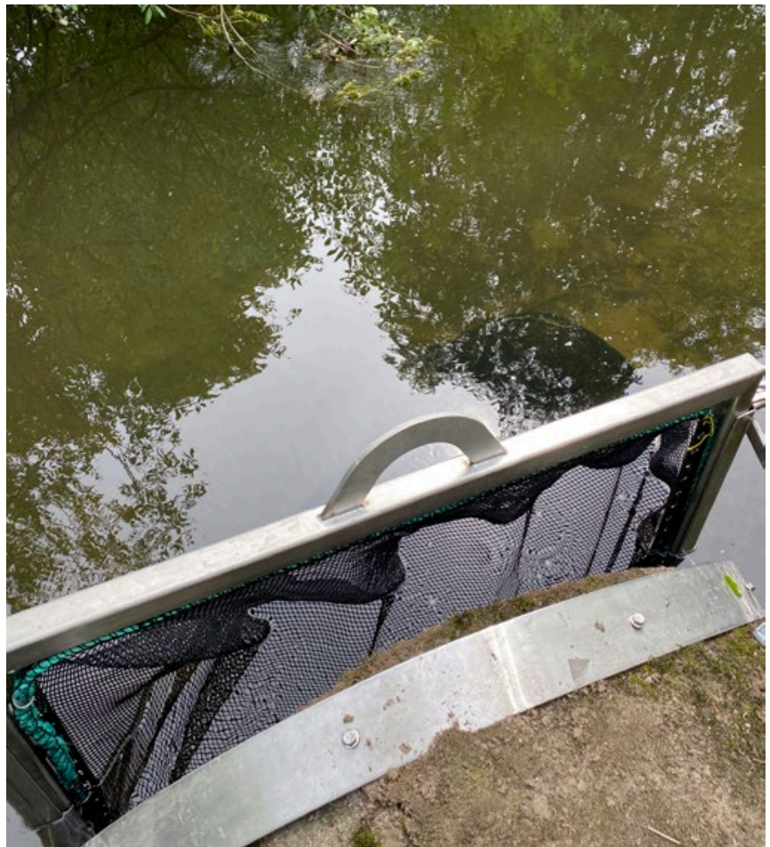
PLASTFANGER montert på overvannsrør i Askerelva.
