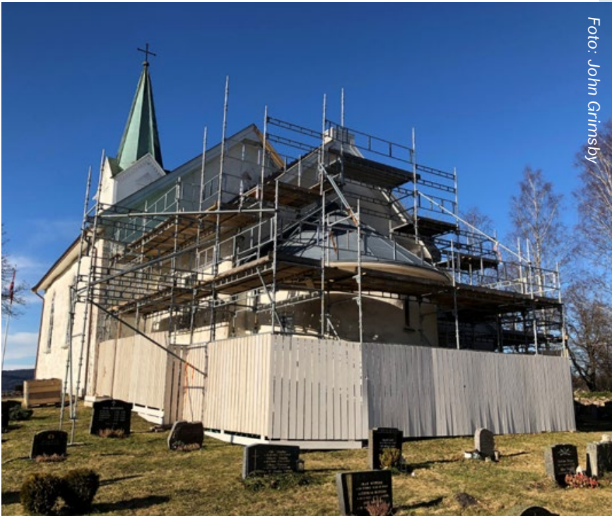
REHABILITERER KIRKE: Asker kirkelige fellesråd bruker i år 5,4 millioner kroner til rehabilitering av Hurum kirke.
