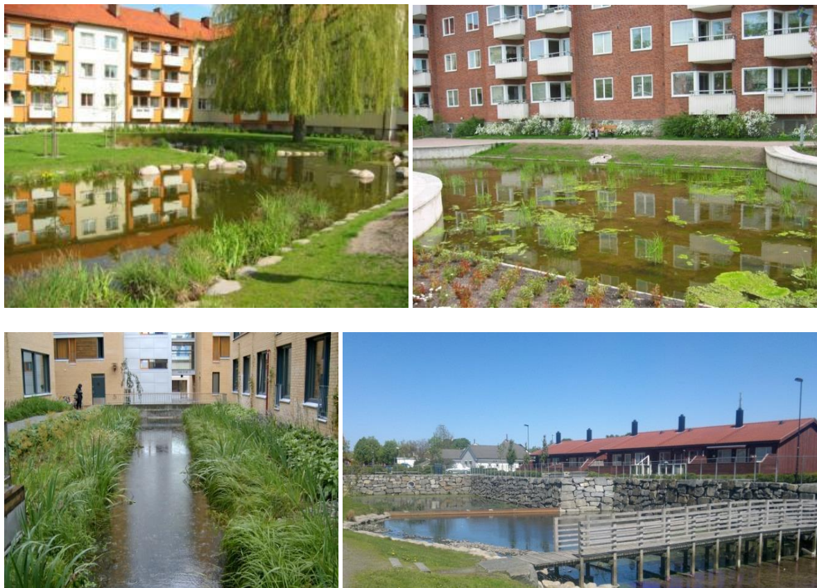
Figur 14: Eksempler på lokale fordrøyningsdammer i boligbebyggelse. Øverst; Dammer i eldre boligbebyggelse i Augustenborg i Malmø. Nederst venstre; dam i Bjølsen studentby i Oslo. Nederst høyre; dam Kleppestemmen i Klepp (foto: Frank Bjørnø). Dammene må ha tett bunn for å opprettholde fast vannspeil og ikke forårsake fuktproblemer på nærliggende bygningskonstruksjon. Foto øverst til høyre viser eksempel på dam med algevekst som skyldes at tilført overvann inneholder for mye næringsstoffer f.eks. tilrenning fra gjødslede arealer (plantefelt, plenarealer).
