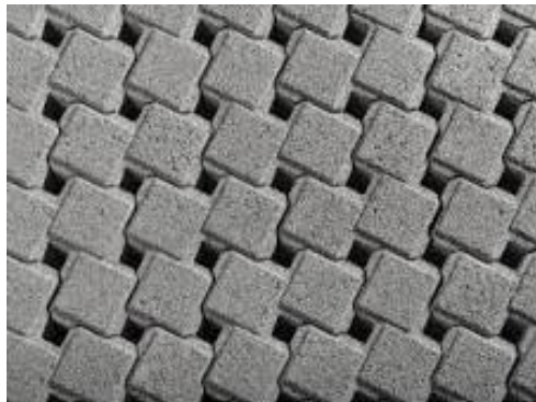
Figur 8: Eksempel på permeabelt armert grasdekke (venstre) og permeabel belegningsstein (høyre).
