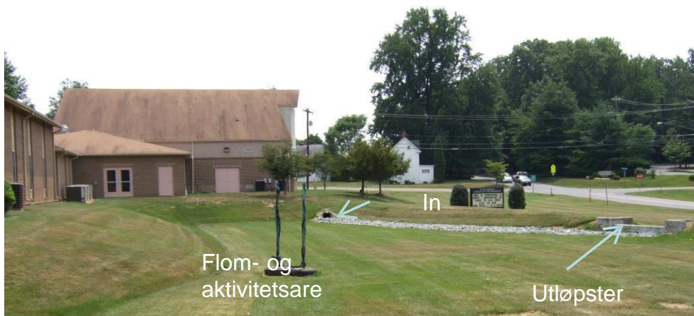
Figur 16: Kombinert tørr fordrøyningsdam og aktivitetsareale for ballspill. Maksimal vannstand ved flom tilsvarer topp utløpsterskel (bilde fra Washington DC).
