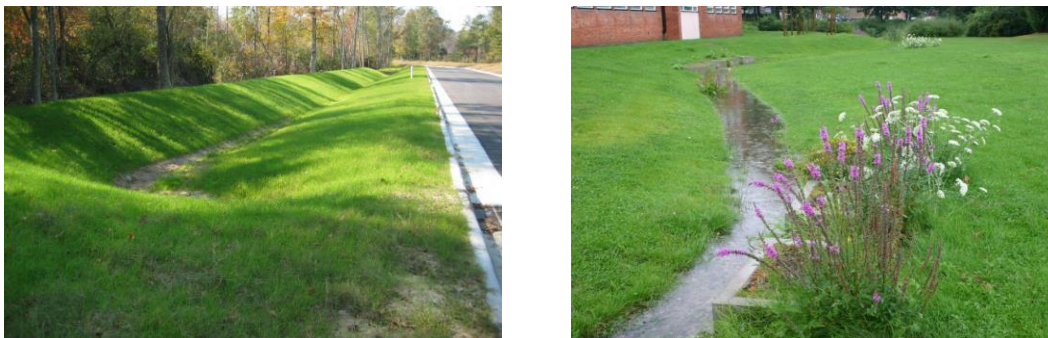
Figur 9: Eksempler på gresskledde vannveier tilknyttet vei i North Carolina, USA (venstre, Foto: Thomas Engineering) og gjennom hage i Augustenborg, Sverige (høyre Foto: T. Leidstedt).
