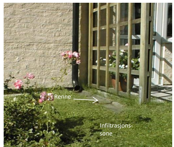
Figur 12: Høyre: Infiltrasjonsløsninger for takvann på arealer med permeable og tette jordmasser. Venstre: Utledning av takvann på renne til infiltrasjon på plenareale (topp: Växjö, bunn: Oslo).
