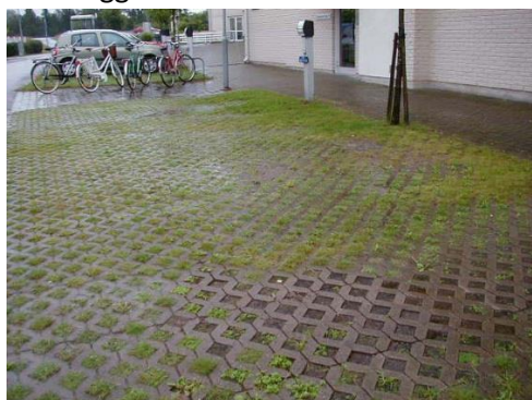
Figur 8: Eksempel på permeabelt armert grasdekke (venstre) og permeabel belegningsstein (høyre).
