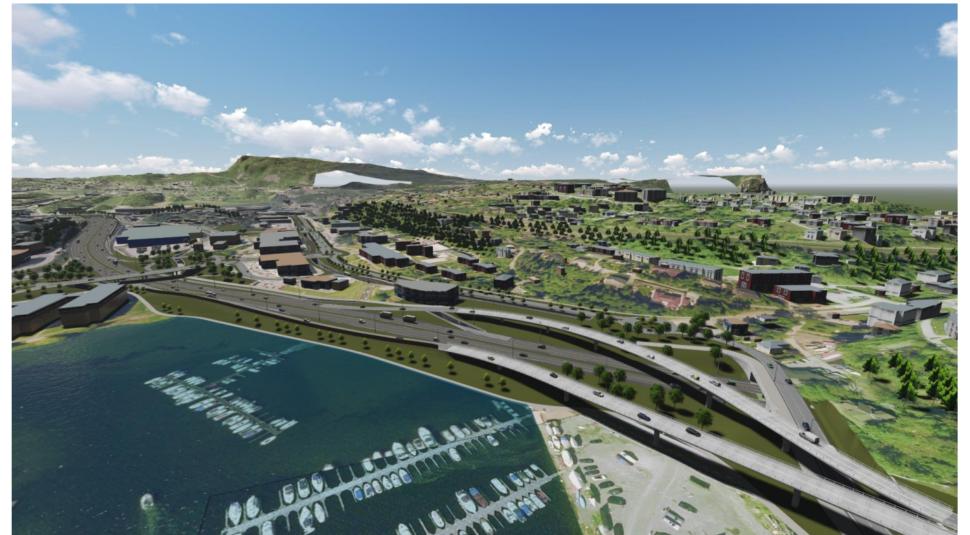
Slependkrysset sett fra sørøst
