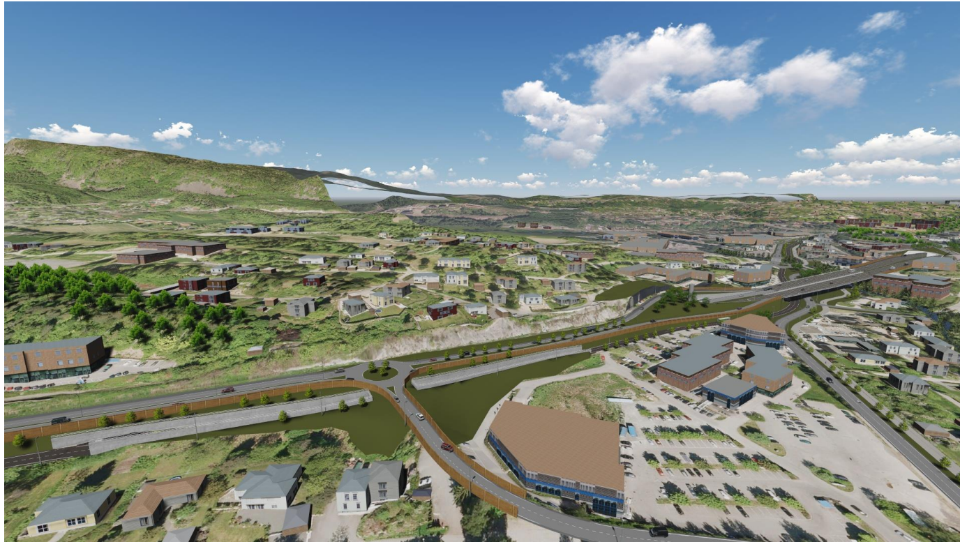
Tunnelpåhugg for E18 og lokalt vegnett ved Nesbru, sett fra sørvest
