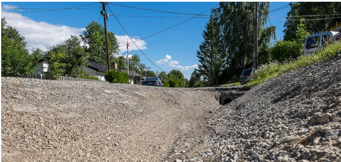
Figur 10 Rehabiliterert grøft. Foto: Tove Lauluten
