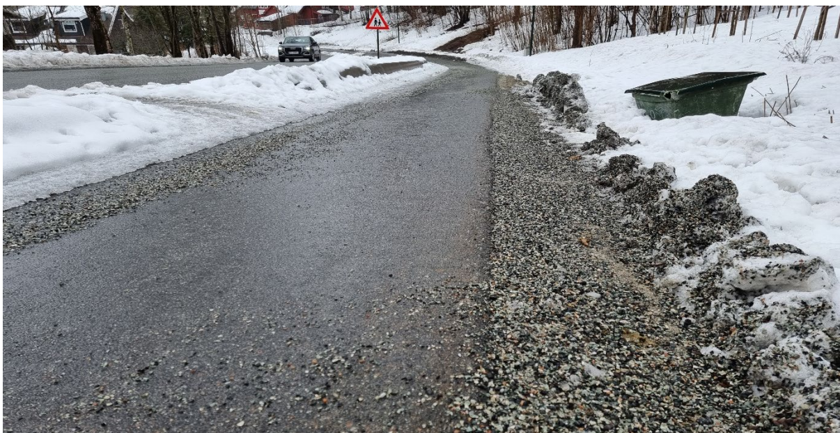
Figur 14 Mye av strøgrusen havner i grøftene og bidrar over tid til tetting av grøftene. Foto: Mari Gabrielsen
