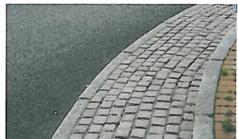
Gatesteinsbelegg med god låsing av ytterkant med granittkantstein.
