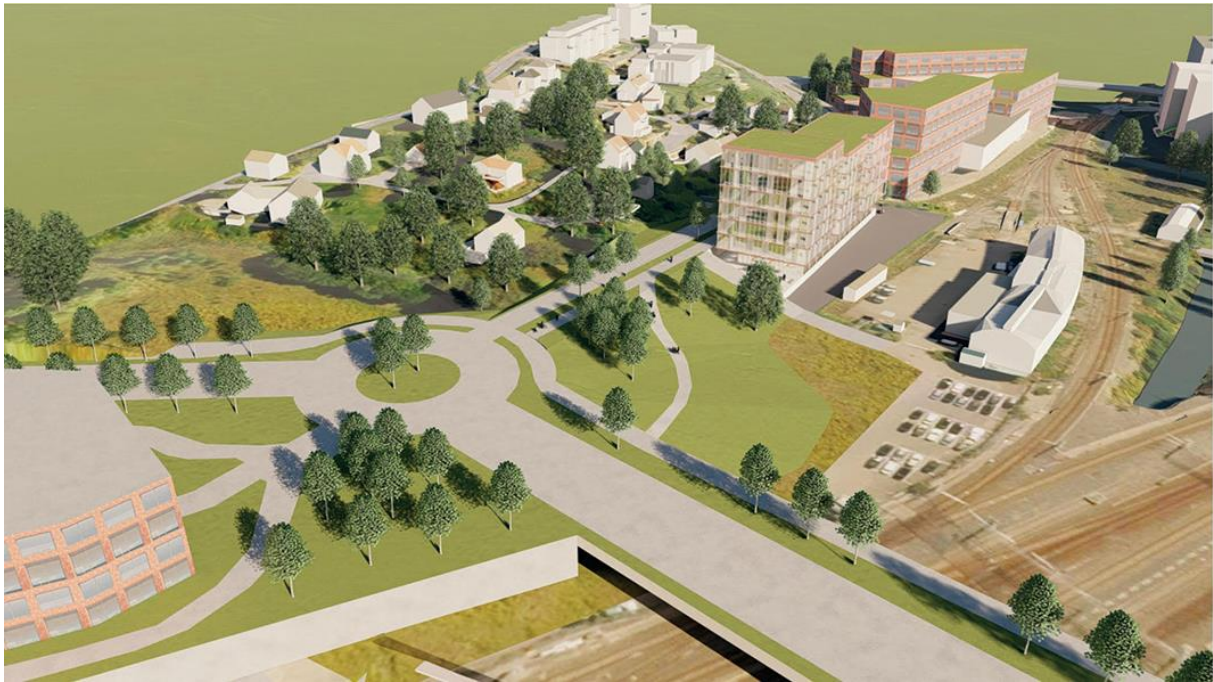
Figur 2: Fremtidig situasjon iht. kommunedelplanen for E18. Ny E18 legges under bakken, mens dagens E18 gjøres om til lokal vei.
