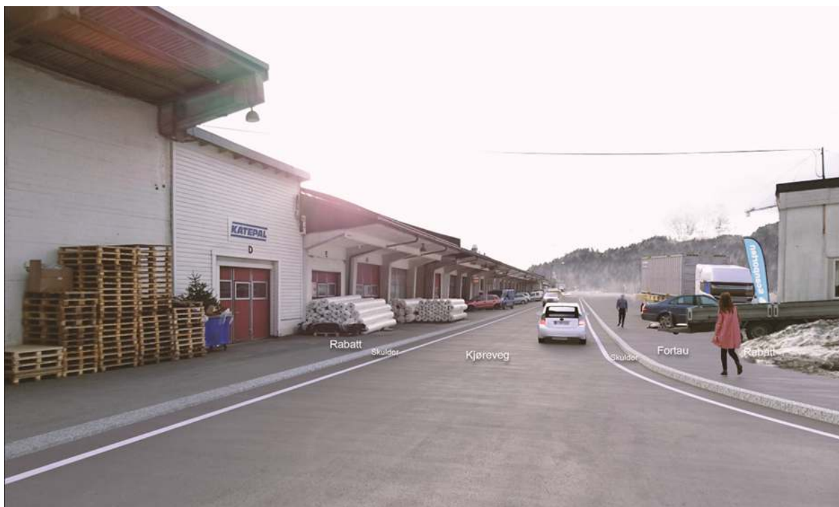
Figur 7. Illustrasjon av Eternitveien slik den ble planlagt i gjeldende reguleringsplan. Veien er ikke opparbeidet.
