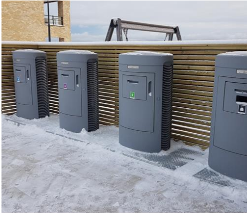
Bilde 6.1: viser nedkastene til avfallssuget i Fologrenda
