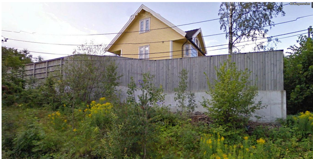
Figur 3 Støyskjerm i Drengsrudveien
