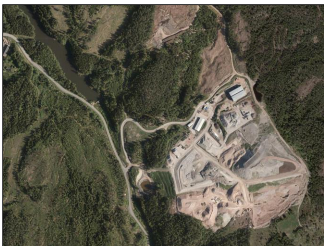
Figur 33: Lindum Oredalen er mottak for forurenset grunn og forurenset jord som er klassifisert som farlig avfall
